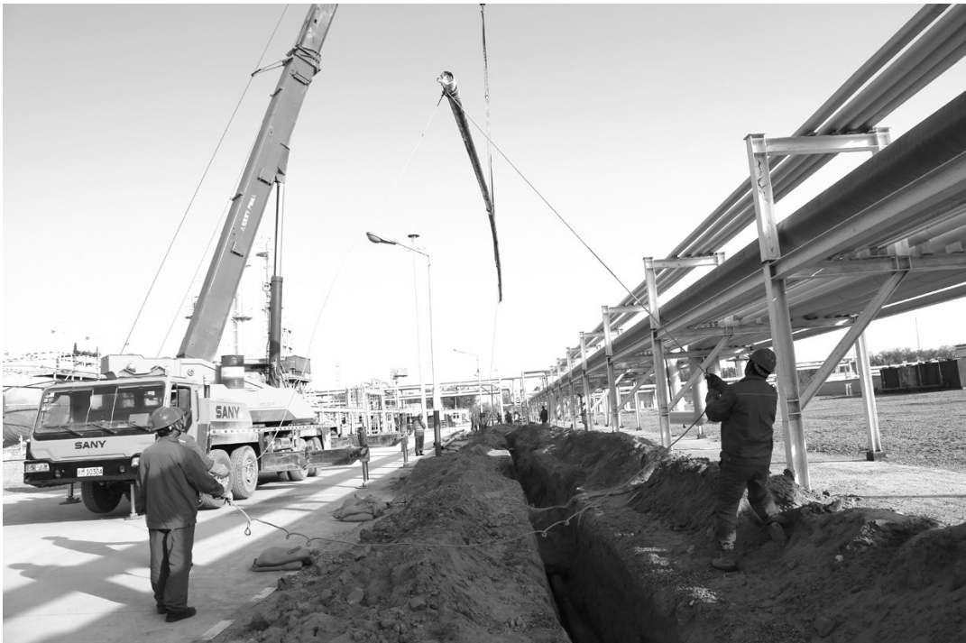
1月28日,时值四九寒冬,新疆南疆气温连续在零下15摄氏度,地处塔克拉玛干沙漠北缘的西北油田采油二厂二号联轻烃站优化增效工程正在火热建设中。该工程2017年8月开工建设,预计今年3月份改造完工。改造后,轻烃站可日增产液化气27.9吨,增产轻烃7吨,年回收硫黄2000吨,实现节能增效和安全环保双赢。 图为施工人员在连接管线。 (胡强/文 朱清峰/图)
